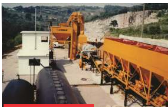
instalação usina CBUQ 1990
